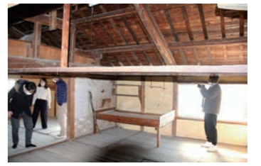
地域内の空き家の視察
